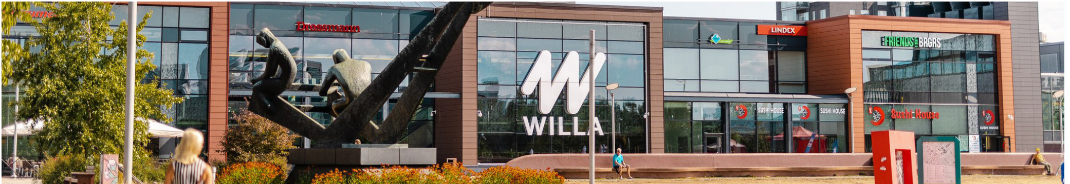
Hyvinkään Willa. Yhteensä 17 900 m 2 vuokrattavaa pinta-alaa. BREEAM-sertifioitu kauppakeskus Hyvinkäällä
